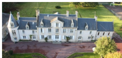
Vue aérienne du Château de Tourmauville à Baron s/odon
